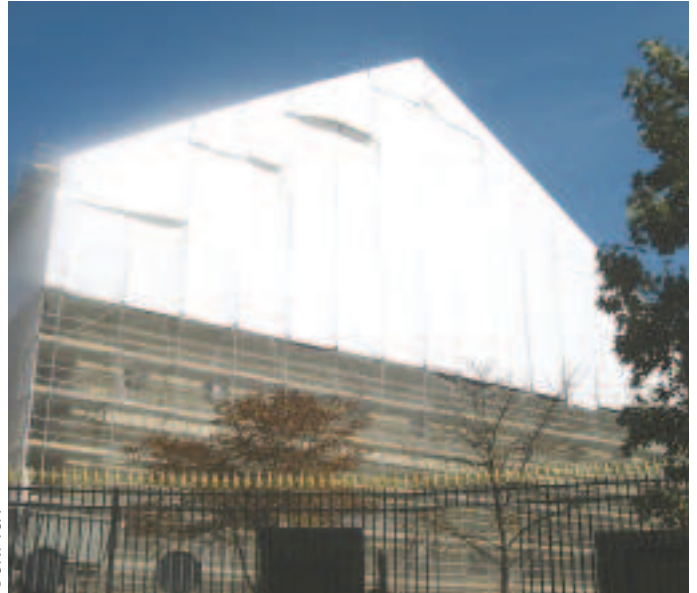
Echafaudage recouvert d'une bâche
